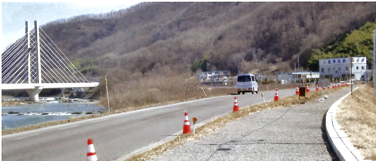
【写真】小牧橋上流、信州名鉄までの堤防道路の拡幅工事 8月頃には完成か
