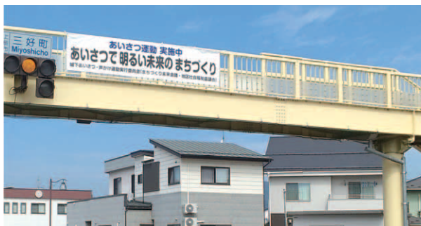
三好町交差点歩道橋への横断幕設置
