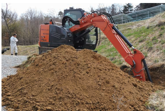
地質調査地点の土をバックホーで掘り返している
