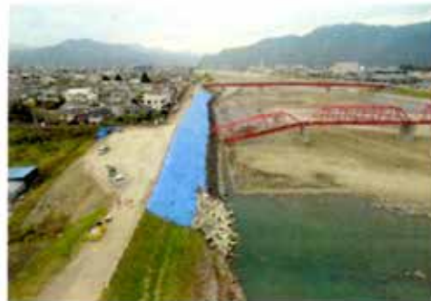
令和元年11月3日状況 (堤防緊急復旧状況)
